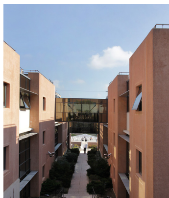
VALBONNE (06) «Les Espaces de Sophia» - Route du Pin Montard
