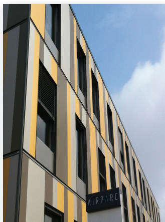
Airparc Lyon Saint-Exupéry - Rue de norvège COLOMBIER-SAUGNIEU (69)
