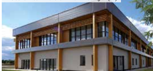
ZAC de Lamirault – Tranche 2 – Bât.E – Collégien (77)
