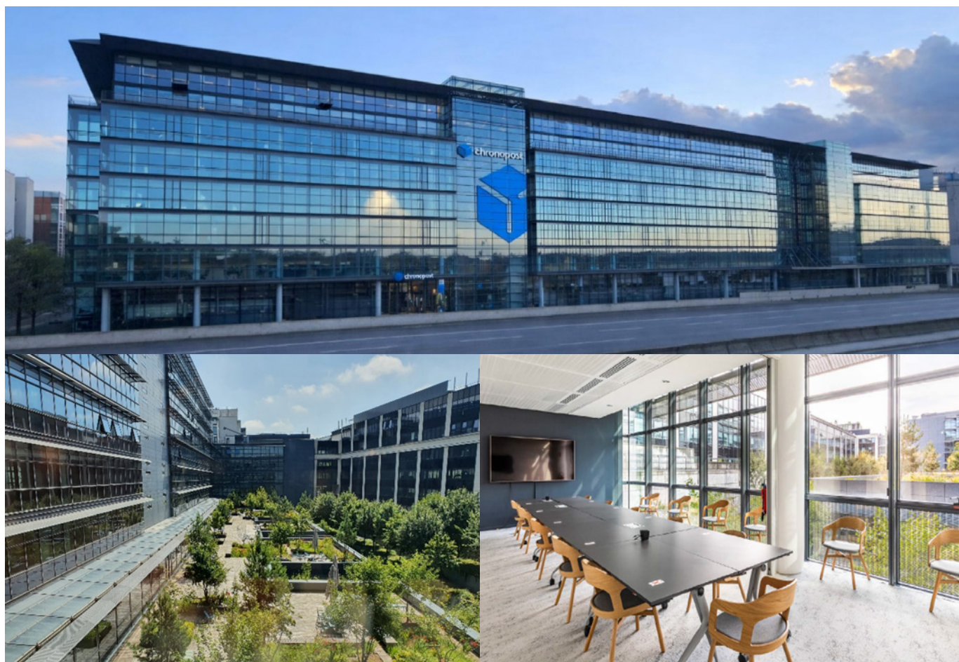
Immeuble Magnetik - Boulevard Romain Rolland - Paris 14 ème
