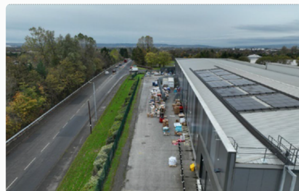
Panneaux photovoltaïques sur l'actif situé à Glasgow.
