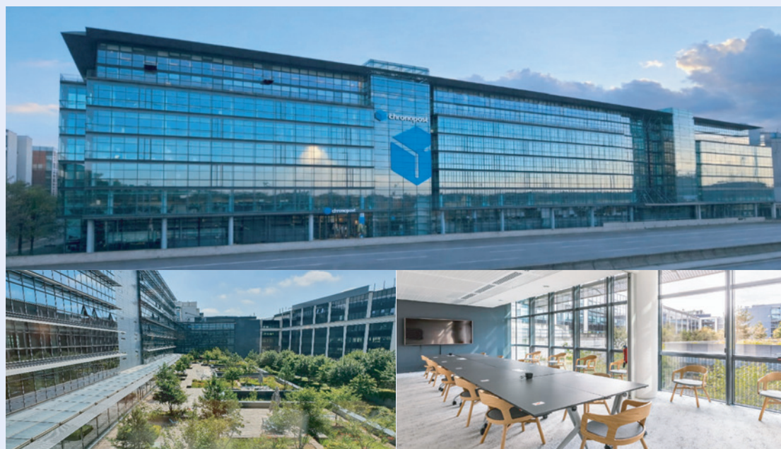
Immeuble Magnetik - Boulevard Romain Rolland - Paris 14 ème
