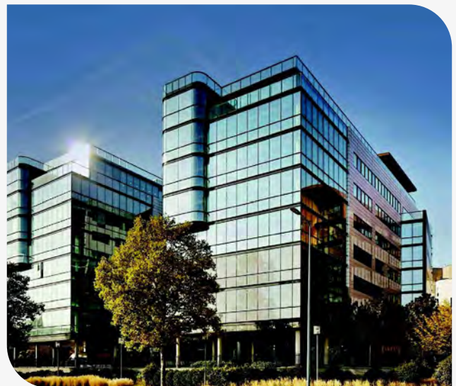
Immeuble « Seine Avenue » - Portefeuille PERIAL Grand Paris
