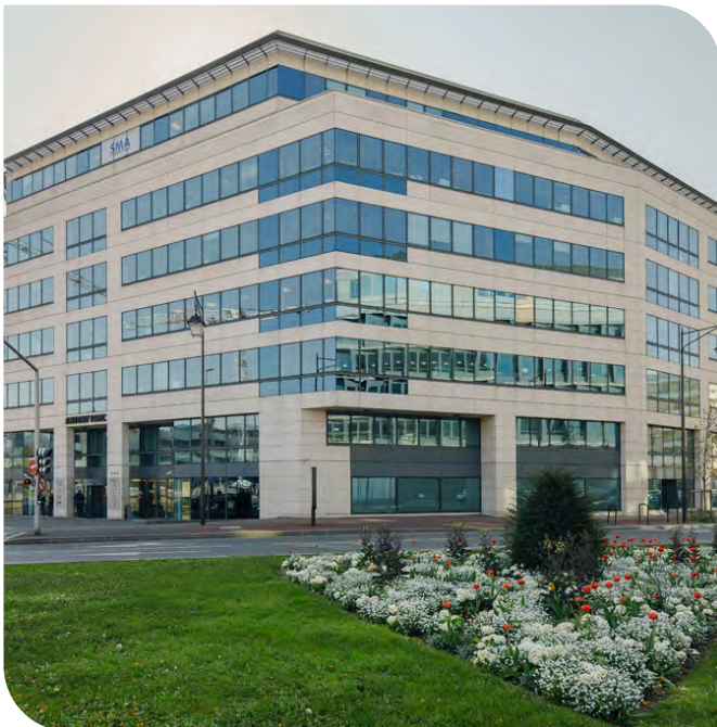
Portefeuille PERIAL O 2 : Immeuble « Antony Parc »
