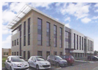
VENISSIEUX (69) Parc du Moulin à Vent Avenue du Docteur Levy
