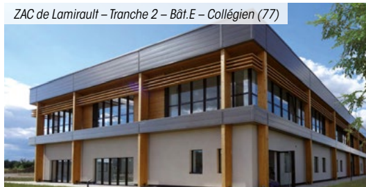
ZAC de Lamirault – Tranche 2 – Bât.E – Collégien (77)
