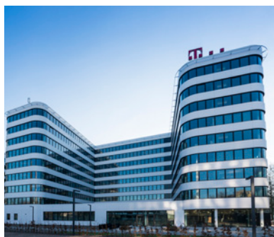
Telekom Campus - Überseering 2 22297 Hambourg - Allemagne
