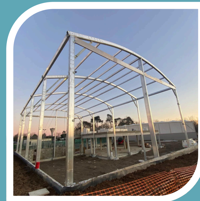
Construction du centre de padel à Camblanes-et-Meynac (33)
