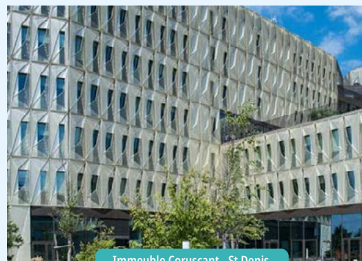
Immeuble Coruscant - St Denis
