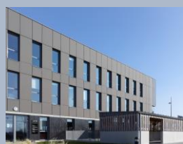
Bureaux Saint-Herblain (Périphérie de Nantes)
