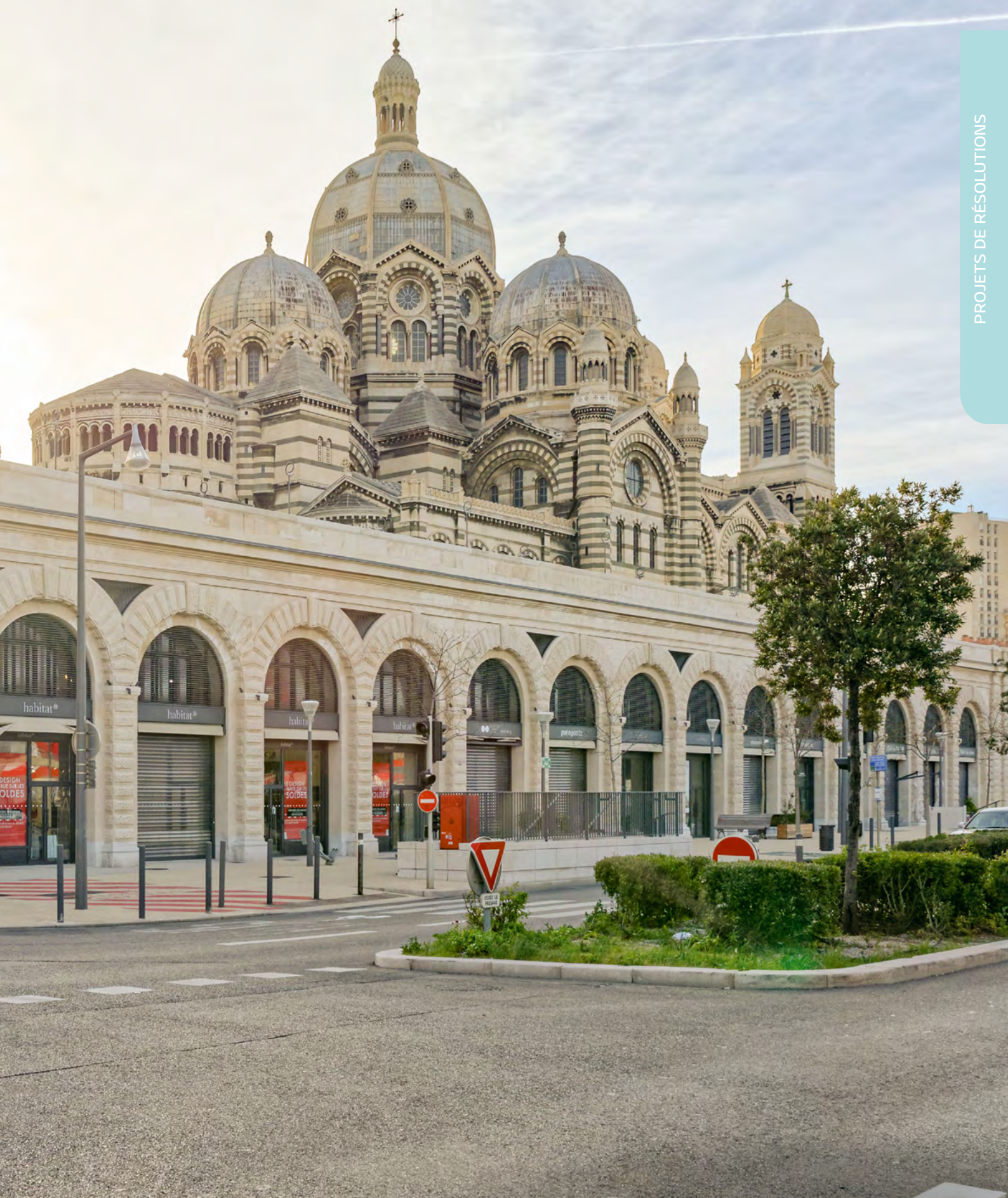
LES VOÛTES DE LA MAJOR – MARSEILLE (13) Droits photo : Olivier Siri
