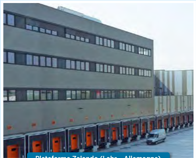
Plateforme Zalando (Lahr - Allemagne)
